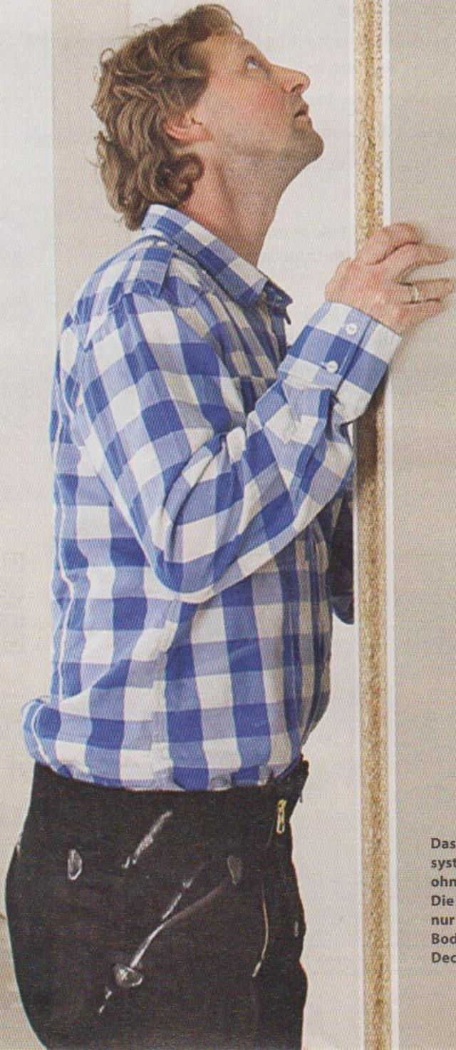
Das Faay-Trennwandsystem kommt völlig ohne Ständerwerk aus. Die Elemente werden nur von Leisten an Boden, Wand und Decke gehalten.
