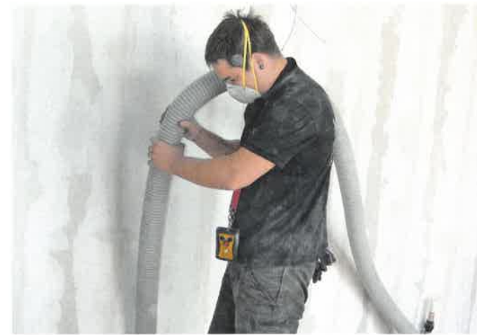
▲ Für die Einblasdämmung wurde ein natureplus-zertifiziertes Produkt verwendet
