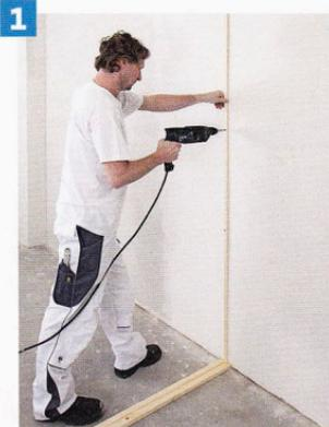
**1** Im ersten Arbeitsschritt wird an Decke und Boden jeweils eine Führungsleiste sowie an der Wand eine halbe Feder montiert.
