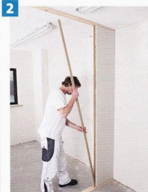
**2** In die zweite Nut wird wiederum eine Feder montiert. Diese bildet den Anschluss für das nächste Element.
