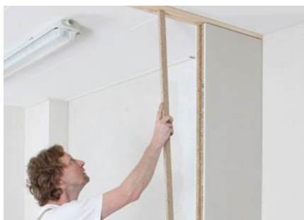
↑ Durch Einschlagen der Spanplatten-Verbindungsfeder in die von FAAYFIX® vorgesehene Nut entsteht eine sehr solide Verbindung zwischen den einzelnen Paneelen
