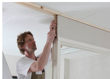
↑ Auch die Verbindungen zwischen Zargenpaneel, Zarge und Wandpaneel werden mit FAAYFIX® zu einem massiven Ganzen verklebt
