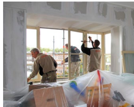
↑ Die Montage erfolgt im Trockenbau: schneller und sauberer!
