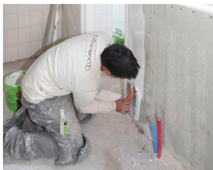
↑ Die Fugen zwischen den Wandelementen müssen plan bengeslossen werden.
