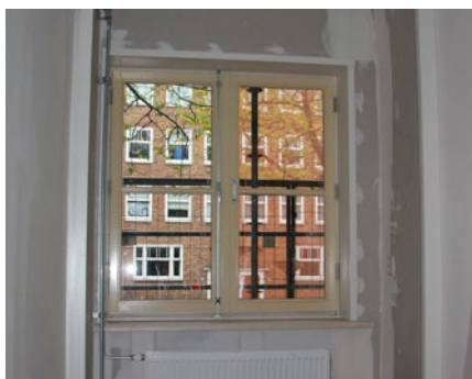
↑ Die Vorsatzwand kann auf unterschiedliche Weisen bearbeitet werden: mit Faay-Wandbesprühung, Farbe, Wandtattoos, Fliesen oder Feinputz.
